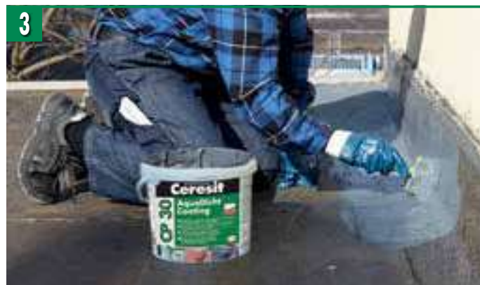
Нанесете хидроизолацията Ceresit CP 30 по ъглите и бордовете с четка, валеж или машинно.
