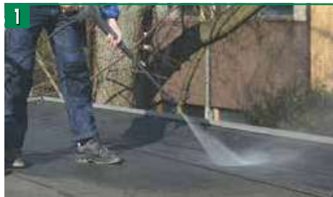
Почистване на покрива
