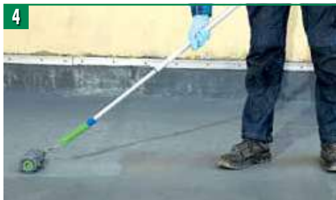
Нанесете хидроизолацията Ceresit CP 30 по основата с четка, валеж или машинно.
